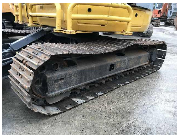
S1-リンク垂み有り
