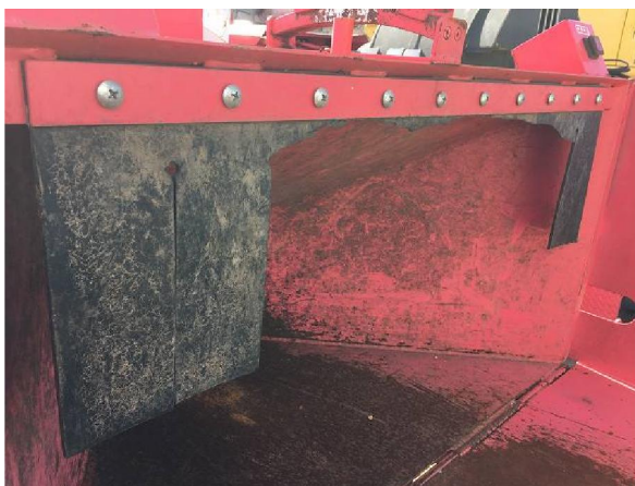
投入口ゴム 破れ、破損
