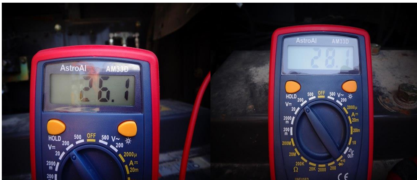
バッテリー電圧測定 (E/G始動前 : E/G始動後)
