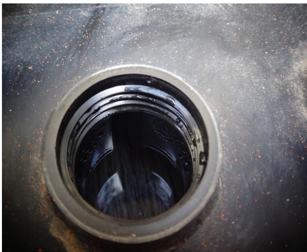
バッテリー液状況写真
