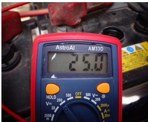
バッテリー電圧測定写真 (E/G始動前)
