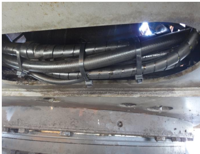
油圧ホース損傷交換後
