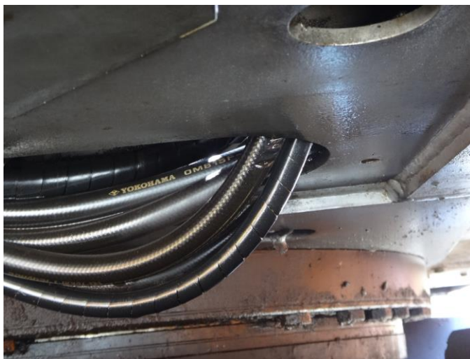
油圧ホース損傷交換前
