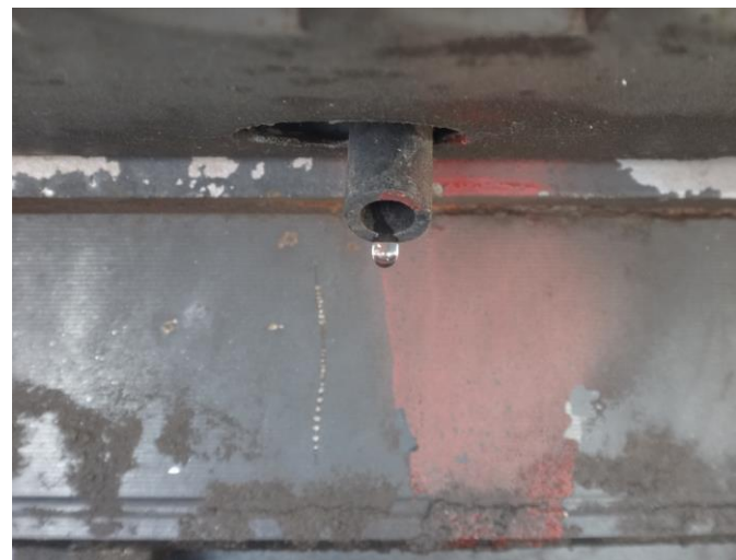
エアコンドレン状況
