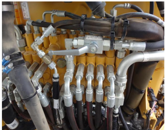
コントロールバルブ状況写真
