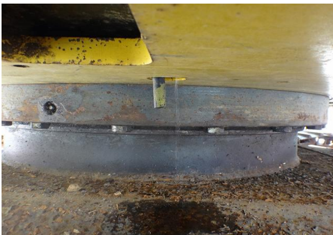
エアコン ドレン状況写真
