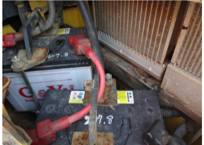
バッテリー状況写真
