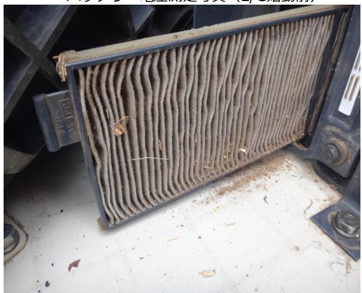
エアコン内気フィルター交換前
