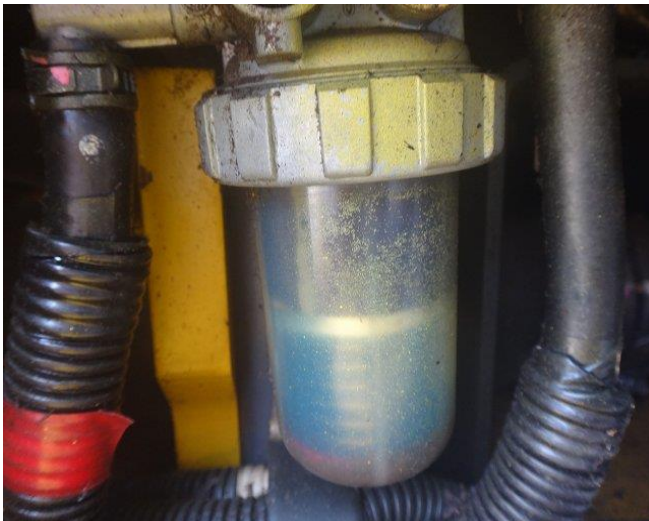
ウォーターセパレーター清掃前
