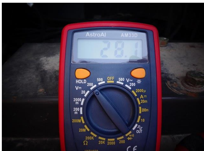
バッテリー電圧測定写真 (E/G始動後)
