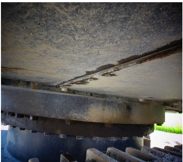
エアコンドレン状況写真①
