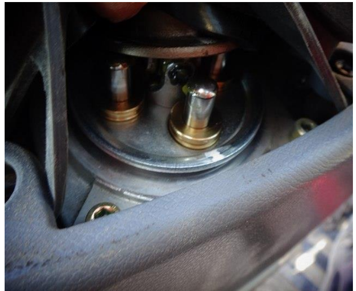
操作パイロットバルブ右側状況写真②
