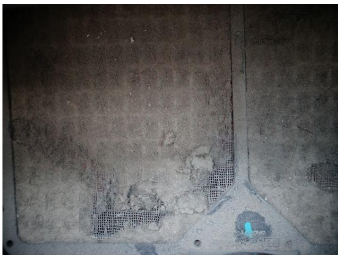
エアコン内気フィルター状況写真②
