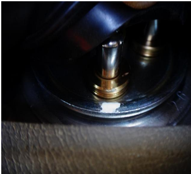
操作パイロットバルブ左側状況写真①
