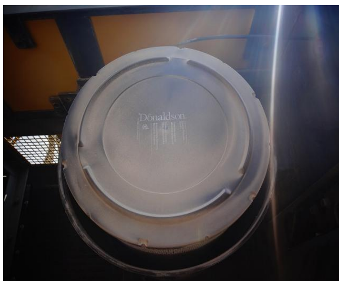
エアエレメント状況写真①
