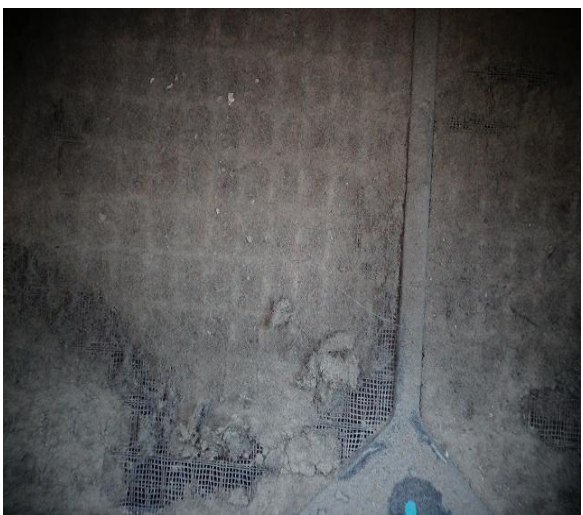
エアコン内気フィルター状況写真①
