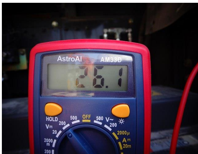
バッテリー電圧測定写真 (E/G始動前)
