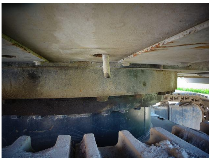
エアコンドレン状況写真②
