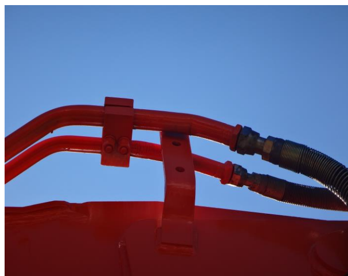
アタッチメント配管状況写真
