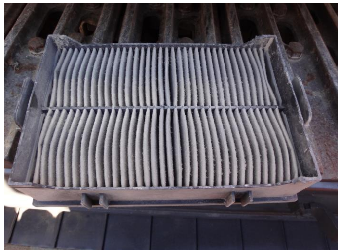
A/C外気フィルター状況写真
