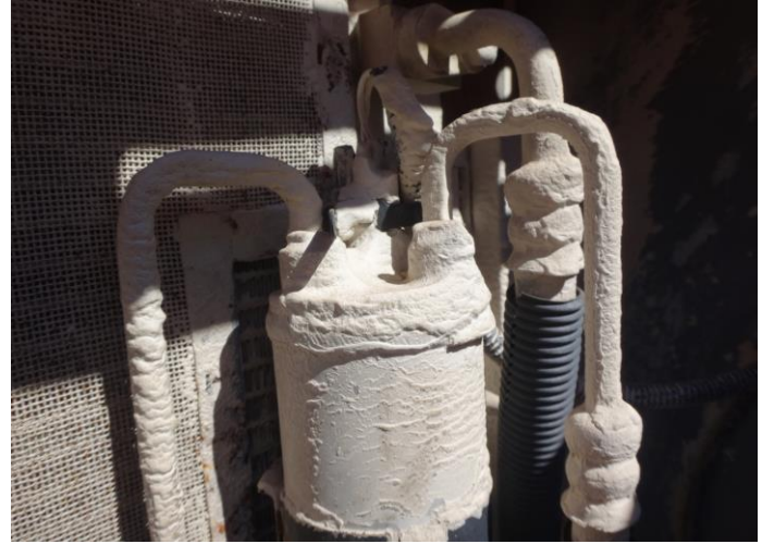
A/Cドライヤー状況写真②
