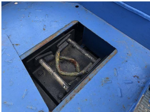
吊り金具状況
