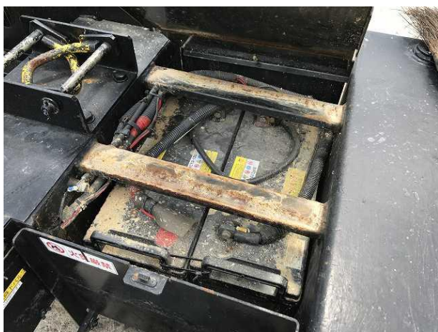
バッテリー取付状態写真
