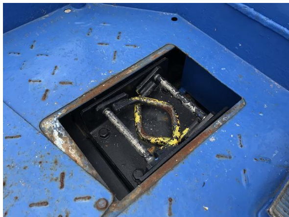
吊り金具状況
