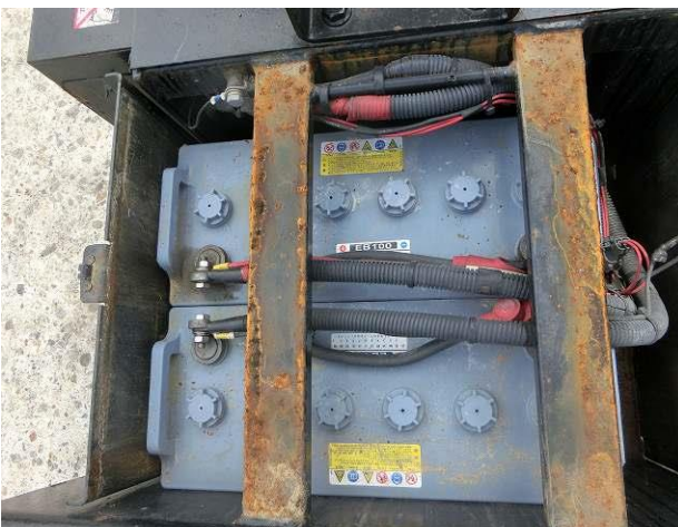
バッテリー取付状態写真
