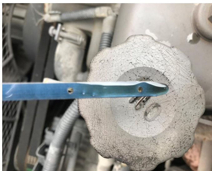
E/Gオイル状況写真
