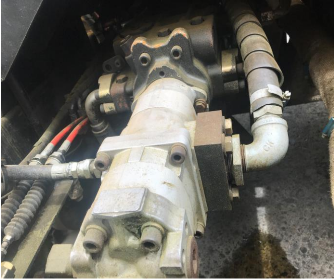
ポンプ全体写真
