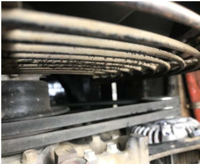
ファンベルト状況写真
