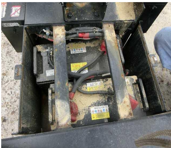
バッテリー取付状態写真
