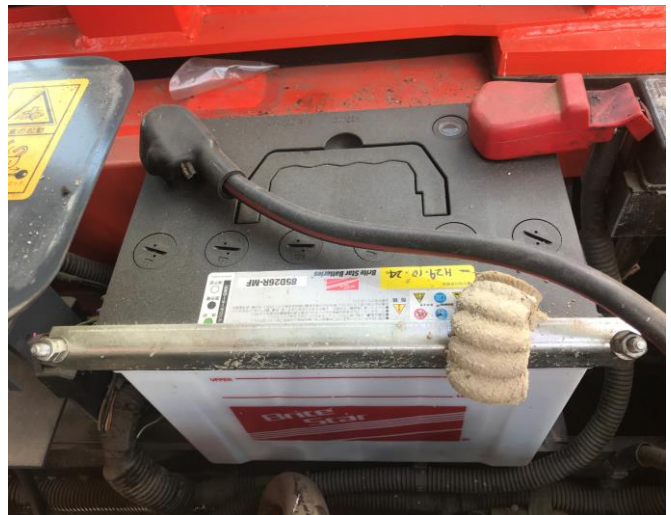
バッテリー状況写真
