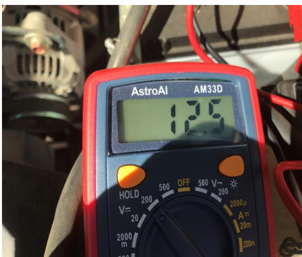
バッテリー電圧測定写真 (E/G始動前)
