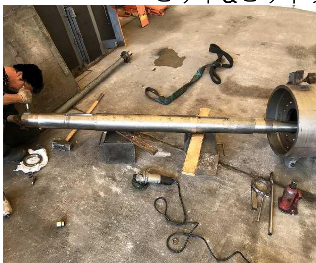
ドラムシャフト交換取り付け
