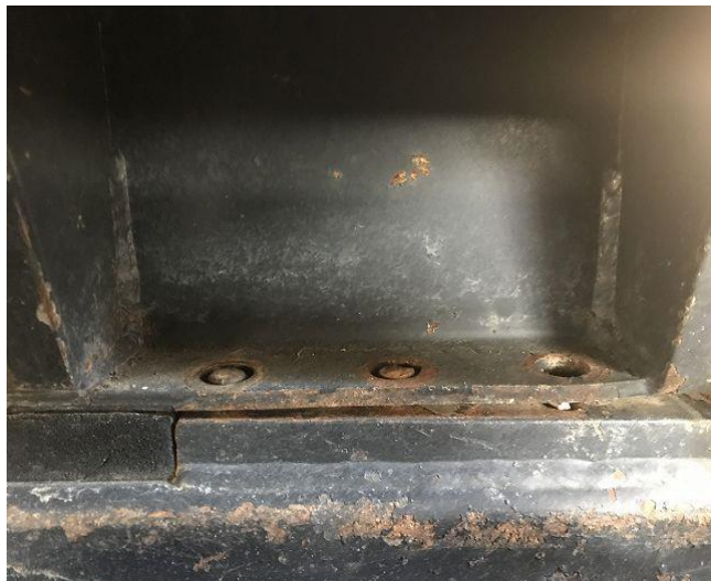
本体取付ボルト折損
