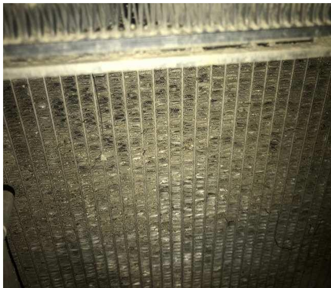
ラジエーターフィン目詰まり
