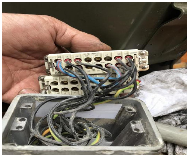
ラジコン配線コネクタ交換及び配線修正
