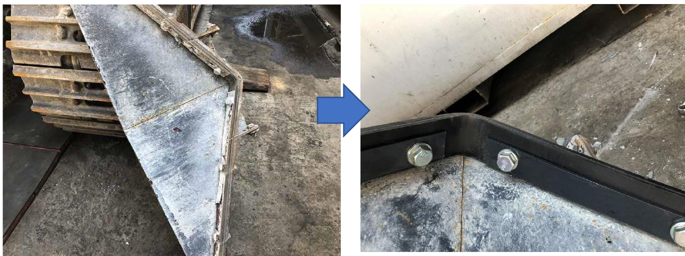
コンベア下部クリーナースクレーパーゴム交換
