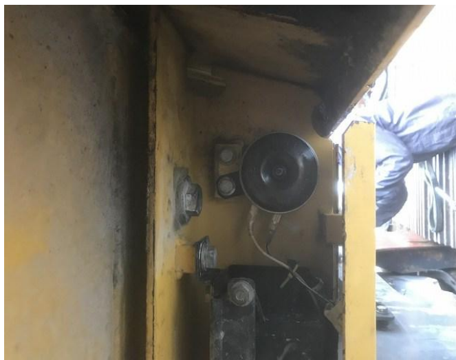
ホーン不良の為交換
