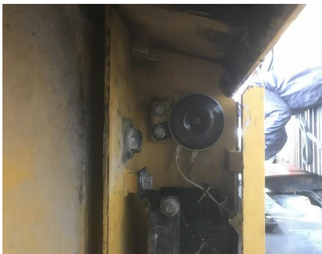
ホーン不良の為交換
