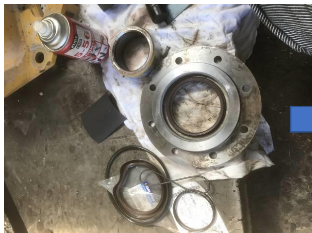
クラッシャーモーターシール交換
