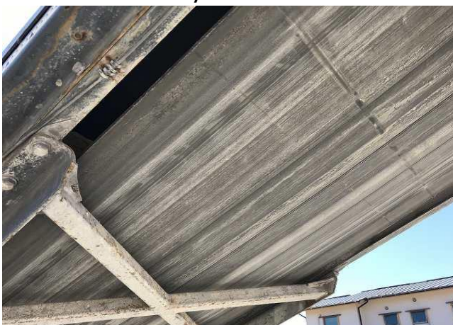
ベルコンゴム劣化 小傷散見
