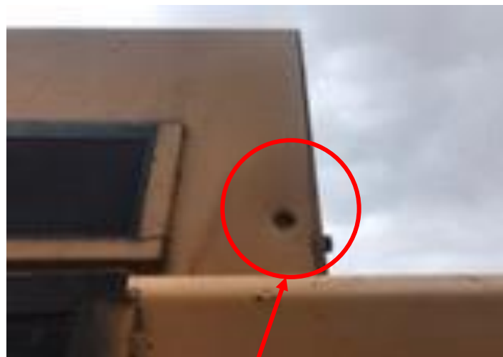
フロントカバーボルト欠損
