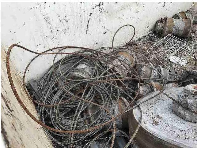
クレーンワイヤー交換
