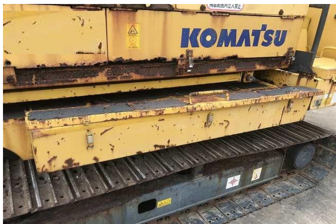
工具BOX板金修理
