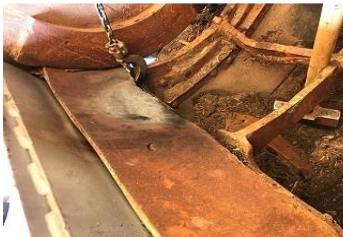
スクリーンガードフレーム変形修正
