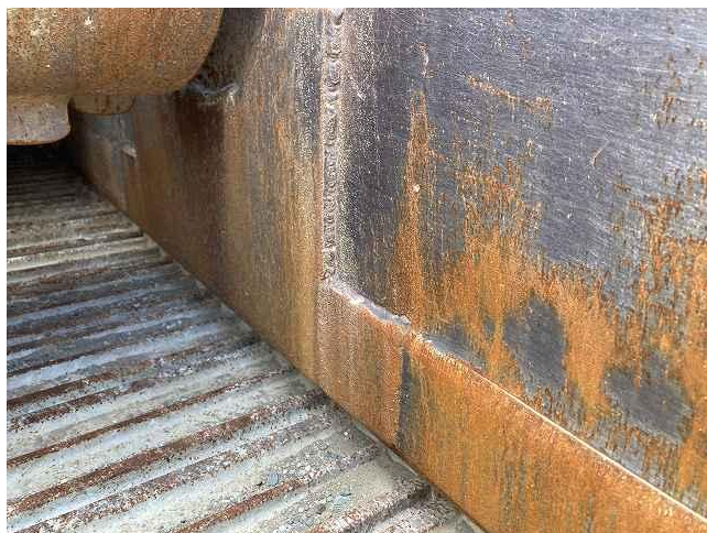
混合室前サイドウォール補強②
