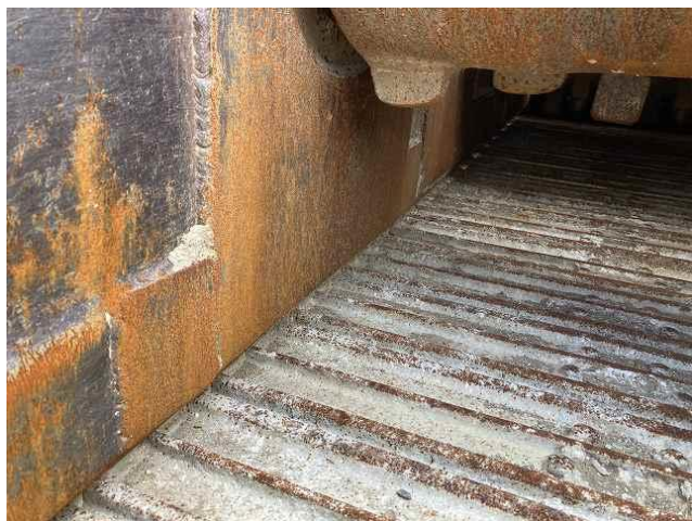
混合室前サイドウォール補強①
