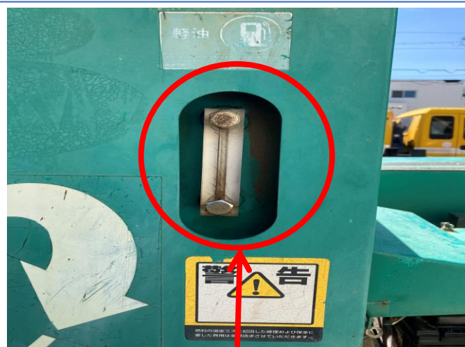
燃料ゲージひび割れ
