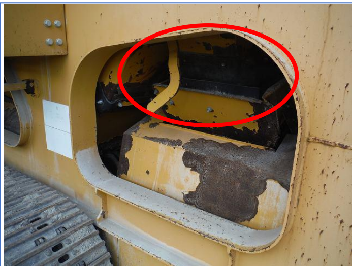
ズリ抜きシューター下部補修跡①
