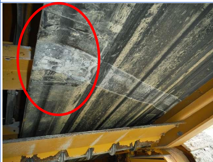
排出コンベアエンドレス部補修跡
