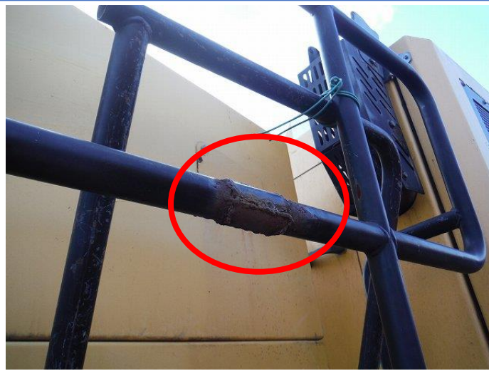
キャットウォーク手摺補修跡
