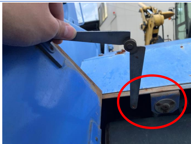
コントロールバルブカバーステー破損
