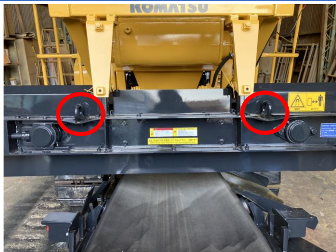
磁選機吊りポイント フレーム歪み①
