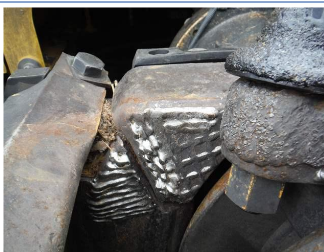
破砕室サイドウォール補修跡②
