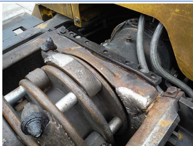
破砕室サイドウォール補修跡①
