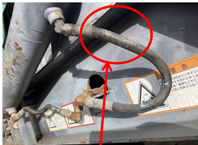
伸縮シリンダー油圧ホースひび割れ
