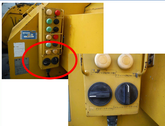
作業速度調節ダイヤル不良
