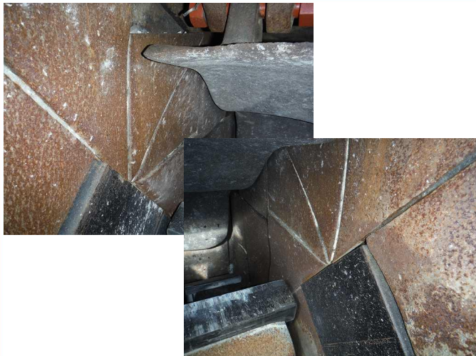
破碎室ライナープレート摩耗
