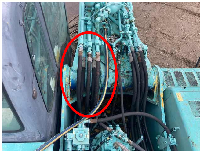
油圧ホース劣化①
