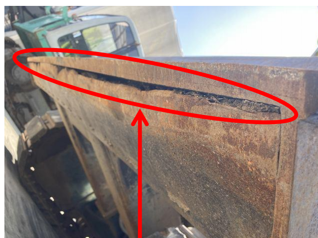
排土板底板摩耗
