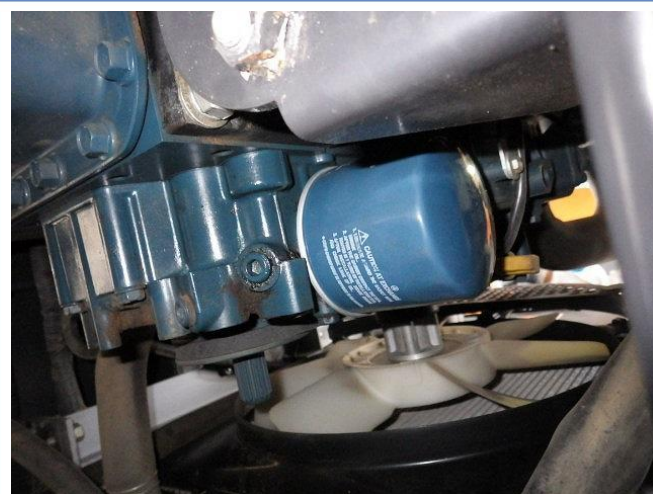
エンジンオイルエレメント交換
