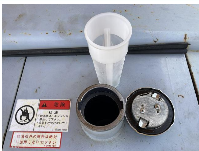
作動油タンク内部点検
