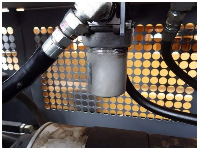
作動油エレメント交換
