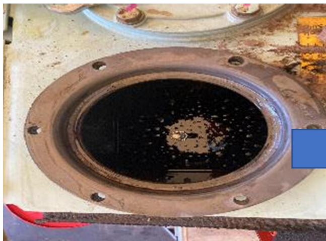
作動油交換及び油量確認
