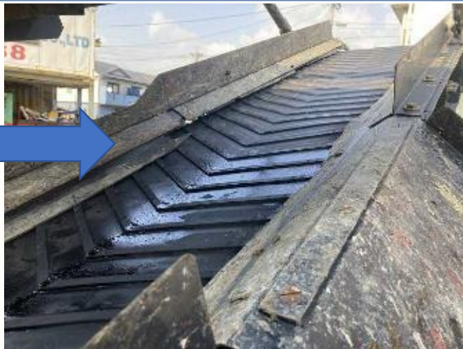
コンベアベルト交換後
