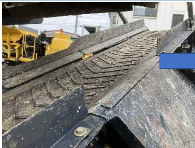
コンベアベルト交換前
