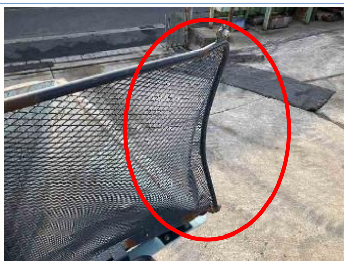
安全柵に一部変形あり
