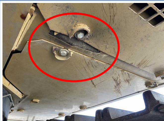
底板一部変形あり
