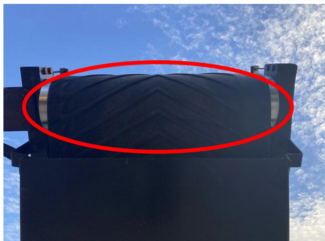
プーリー磁選機交換
