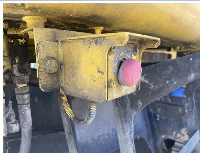
非常停止スイッチ不良交換(1か所)
