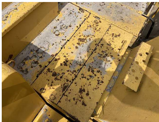
混合室裏側カバー錆び
