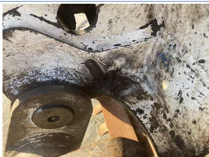
溶接補修跡 ②
