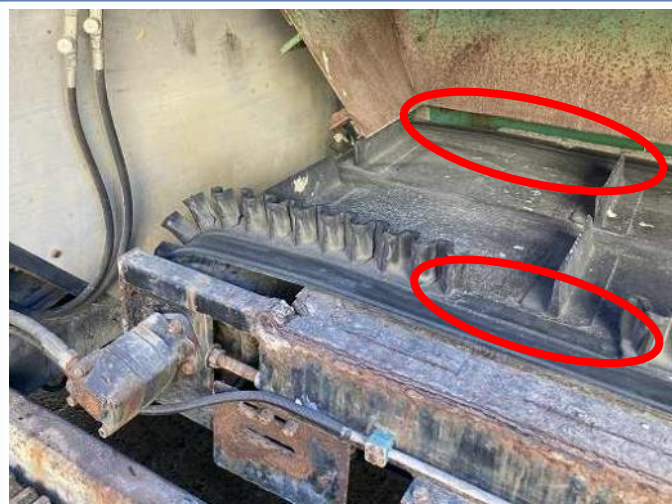
コンベア波栈ゴム一部脱落
