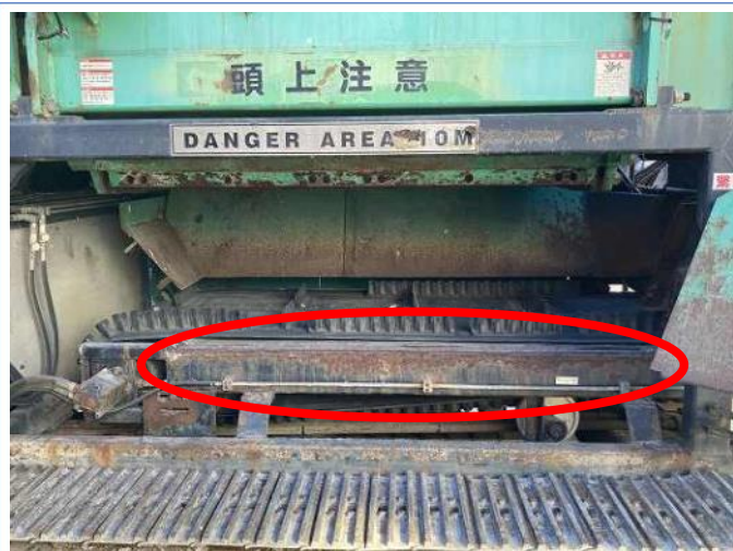
コンベアフレーム表層腐食
