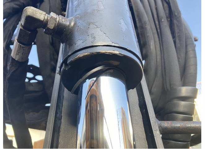
グラップルブームシリンダシール破損
