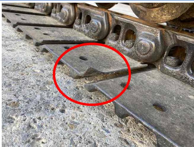
シュープレート変形
