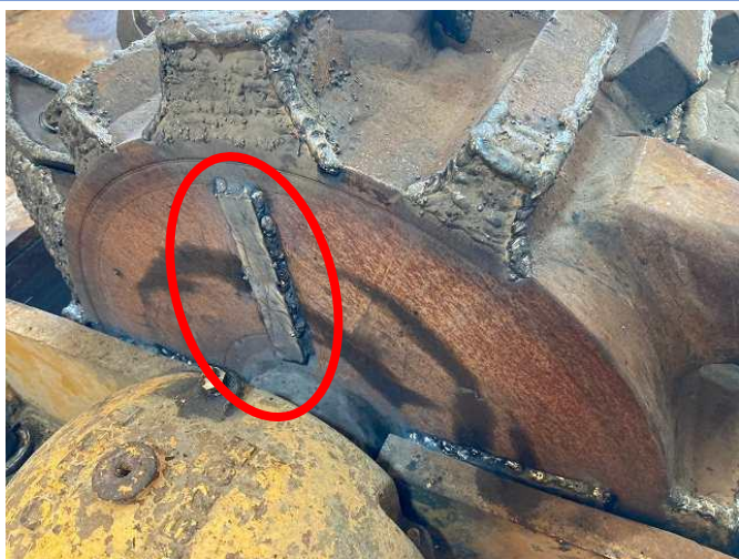
破砕ドラム側面掻き出し板溶接
