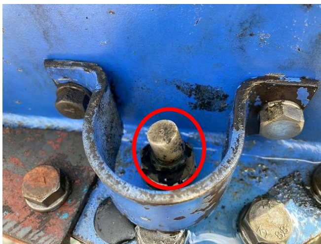
アタッチメントスィベルジョイント油漏れ修理
