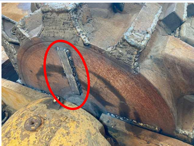
破砕ドラム側面掻き出し板溶接
