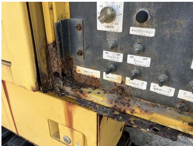
外装カバー錆腐蝕あり②(操作パネル)
