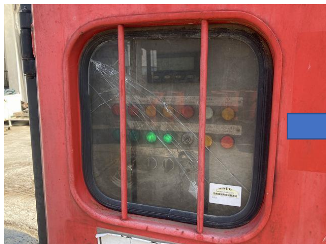
パネルガラス割れ⇒アクリルへ交換(2024年10月作業)
