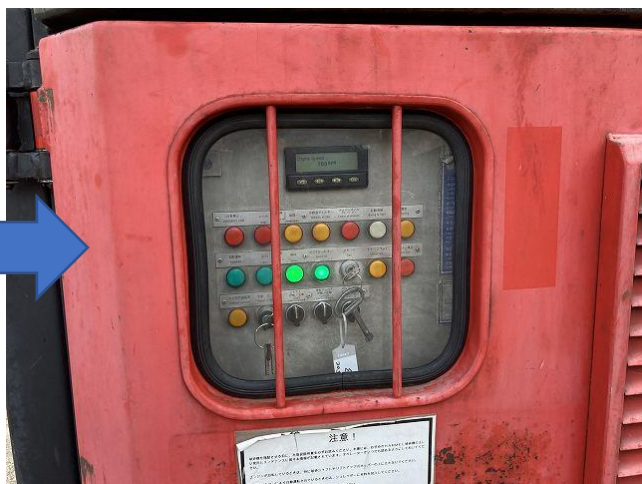
パネルガラス割れ⇒アクリルへ交換(2024年10月作業)
