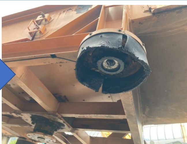
ロータリーベアリング分解清掃
