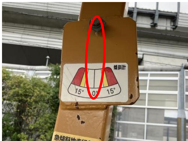
傾斜計 針 欠損
